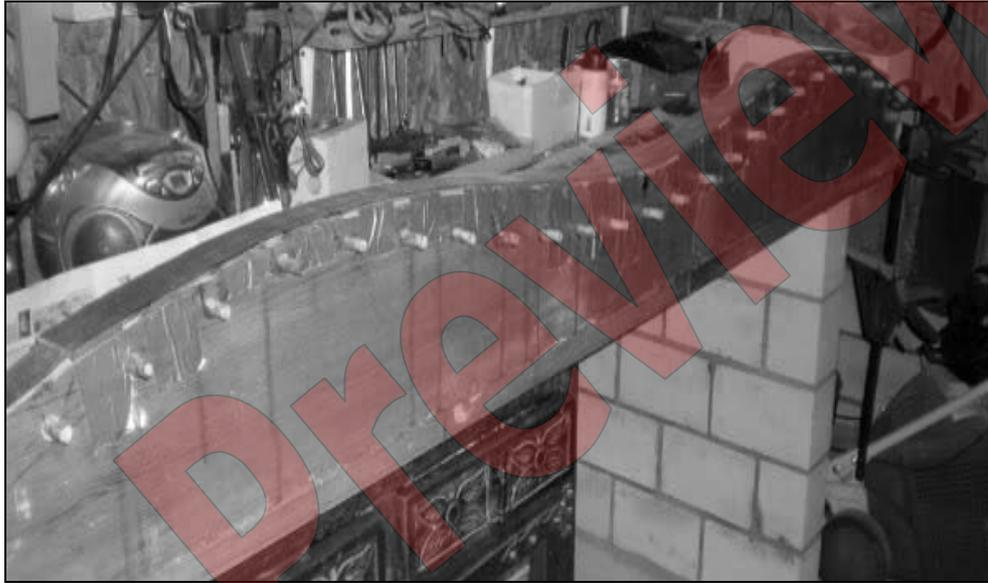
*Bild 21: Die Bogenform ist fertig und wir können mit dem Bau des Bogens anfangen*
